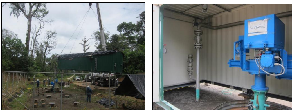
Fotografía N°7. Instalación MLVs Cruce Río Pinduyacu
