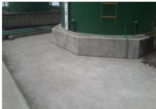
Fotografía N°5. Mantenimiento y limpieza de cubetos de contención
