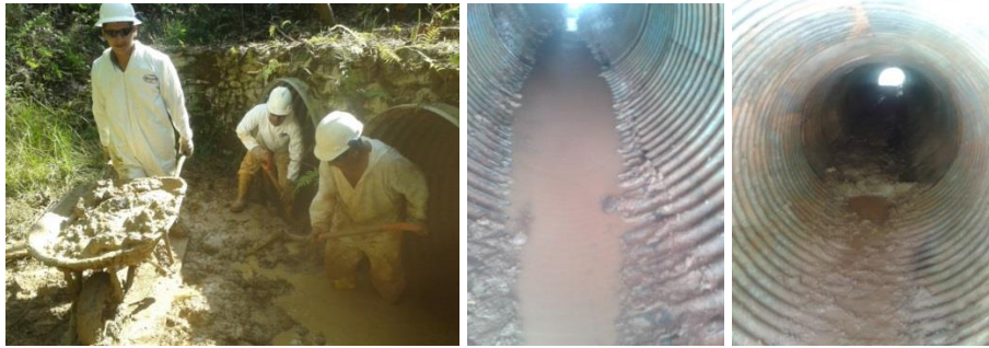
Fotografía N°3. Inspección y limpieza pasos deprimidos
