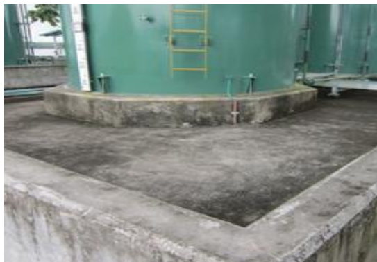
Fotografía N°5. Mantenimiento y limpieza de cubetos de contención
