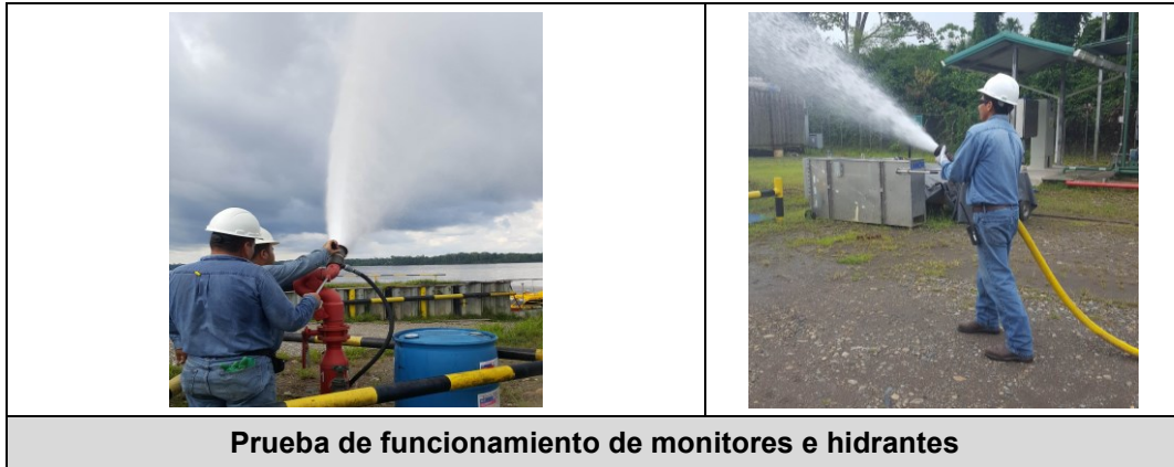
Fotografía N°7. INSPECCIONES DE EQUIPOS CONTRA INCENDIOS
