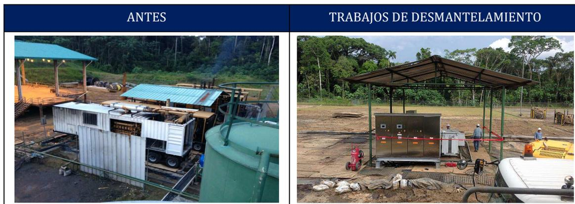
Fotografía N°2. DESCONEXIÓN GENERACIÓN TEMPORAL
