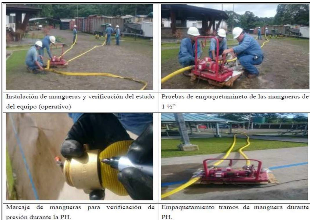
**Fotografía N°13.** PRUEBAS HIDROSTÁTICAS (PH) DE MANGUERAS CONTRA INCENDIOS
