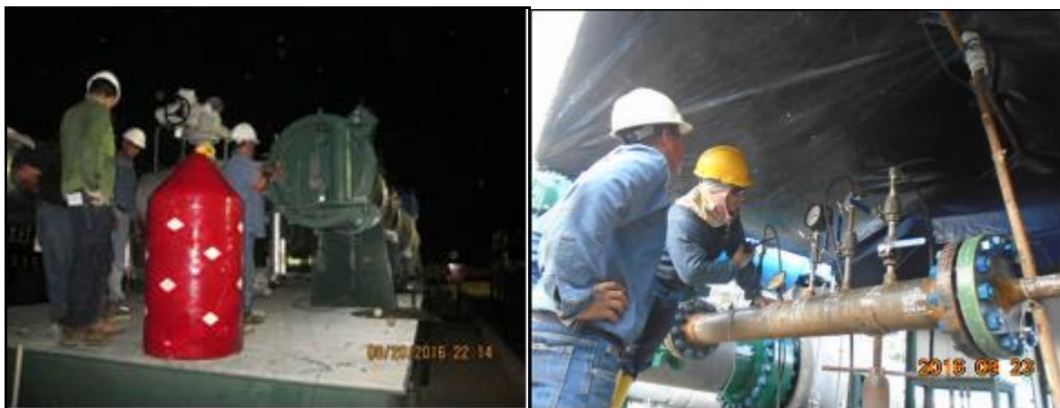
Fotografía N°9. Pruebas hidrostáticas y limpieza de la línea
