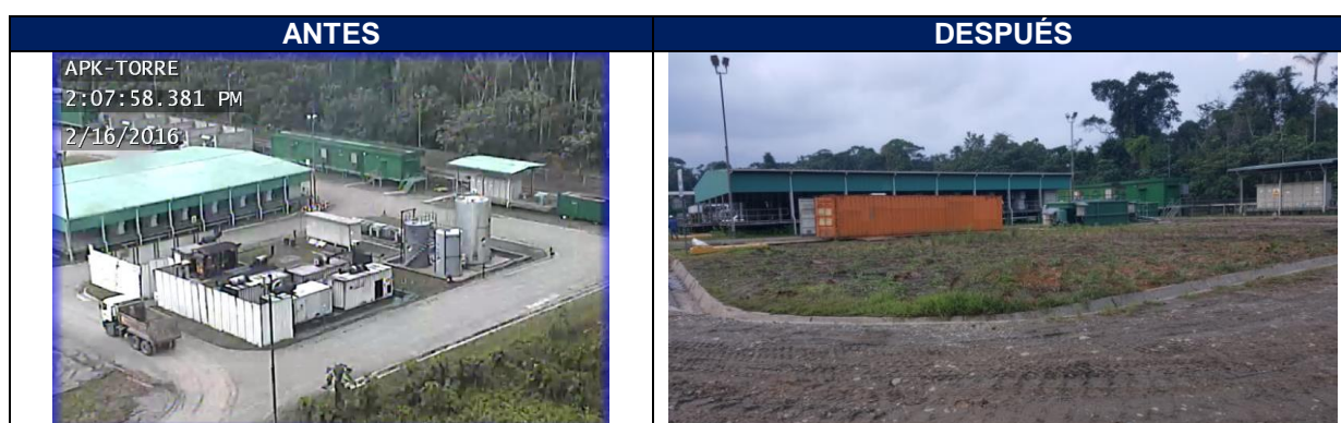
Fotografía N°1. DESMANTELAMIENTO ÁREA DE GENERACIÓN TEMPORAL APAIKA
