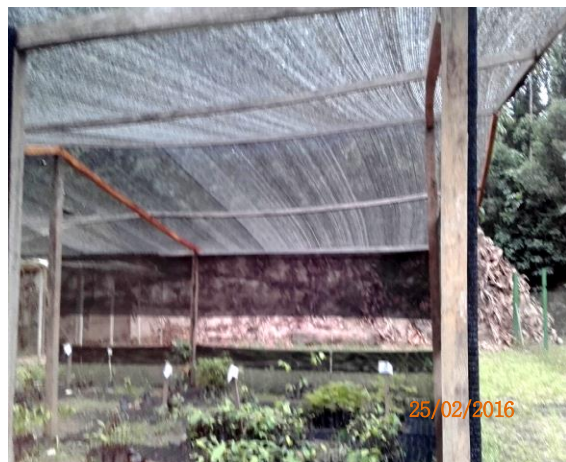
Reparación interna de la estructura del vivero K1
