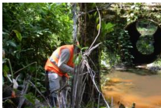
Paso deprimido #52 Abscisa 10+320
