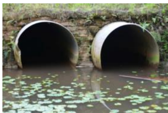
Paso Deprimido #53 Abscisa 10+900
