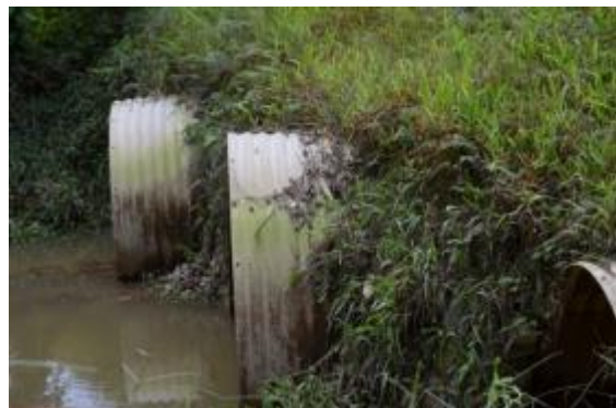
Paso Deprimido #22 ubicado en la abscisa 3+840
