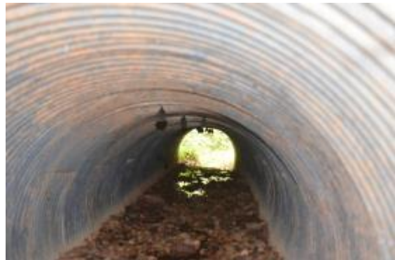
Interior del Paso Deprimido # 28 ubicado en la abscisa 5+200
