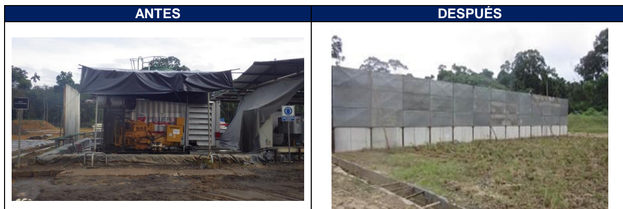
Fotografía N°2. INSTALACIÓN PANTALLA ACÚSTICA ÁREA DE GENERACIÓN TEMPORAL NENKE
