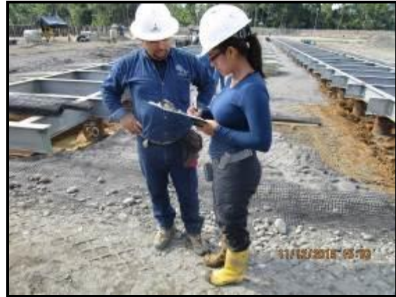
Verificación de resultados previa descarga de agua (MAE)
