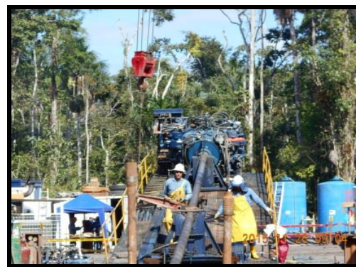
Taladro horizontal cruce subfluvial
