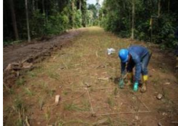
Monitoreo en el DDV sigue en construcción pruebas de prendimientos 47+500
