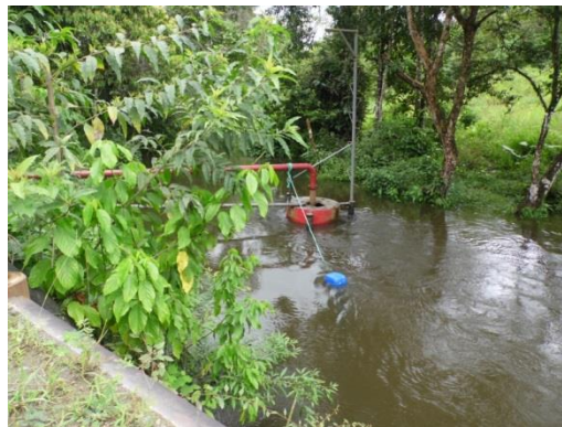
Fotografía 4-10. Captación de Agua Tipo
