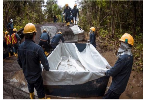
Fotografía 4-3. Colocación del geocontenedor
