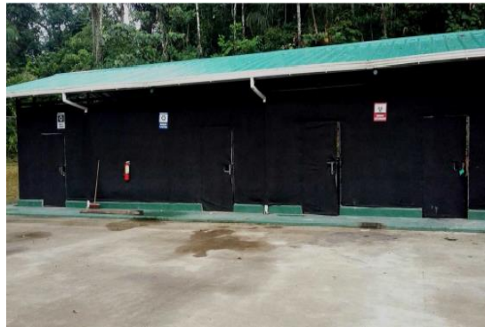
Fotografía 4-8: Celdas de almacenamiento temporal de desechos
