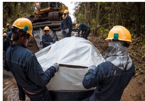
Fotografía 4-5. Sellado del geocontenedor
