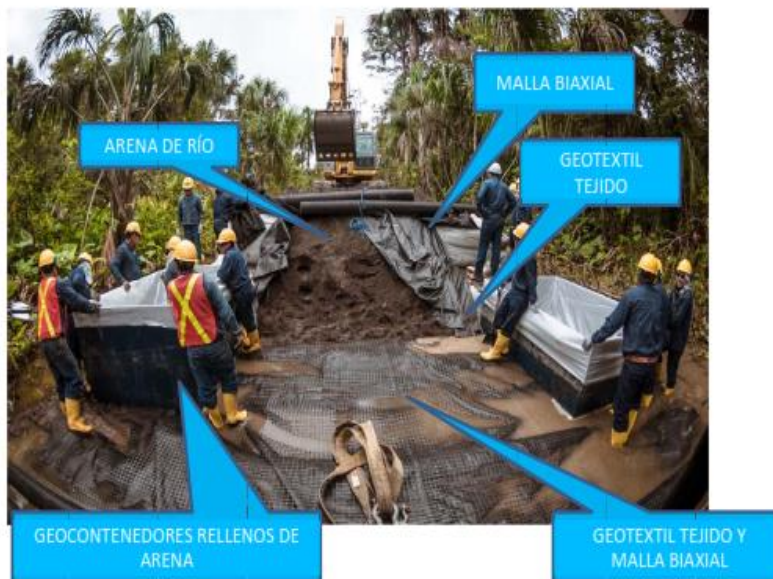
Fotografía 4-1. Construcción de Geocontenedores
