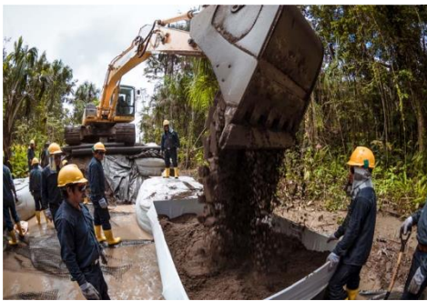
Fotografía 4-4. Relleno de geocontenedor
