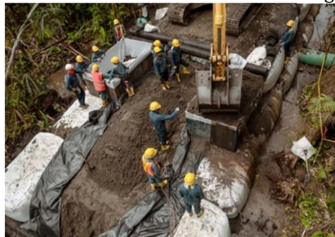
Fotografía 4-6. Proceso constructivo de la segunda capa
