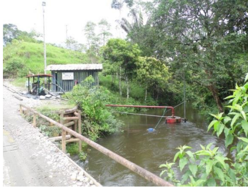
Fotografía 4-9. Caseta de captación de agua tipo
