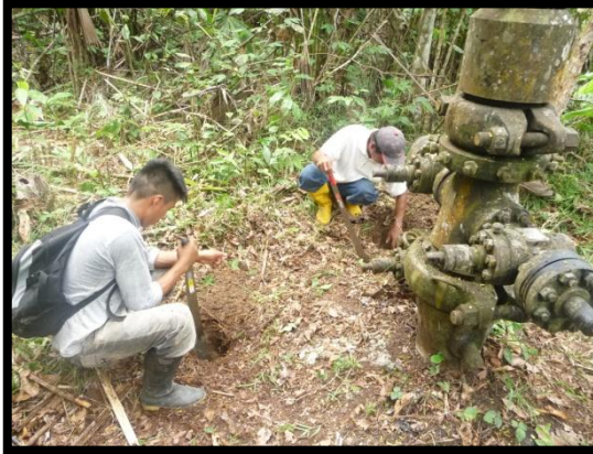
Fotografía 64: Calicatas para obtención de muestras
