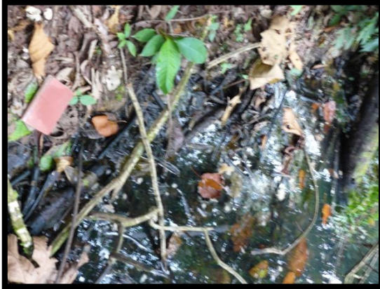
Fotografía 10: Geomembrana cubierta de material vegetal
