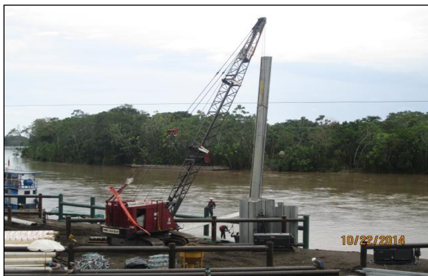
La fotografía muestra el proceso de hincado de tablestacas para la construcción de la pantalla de protección de la Zona de Embarque Miranda. Fuera del Parque Nacional Yasuní .
