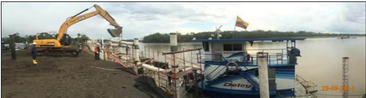
La fotografía muestra el proceso de construcción de la pantalla de protección de la Zona de Embarque Miranda fuera del Parque Nacional Yasuní .
