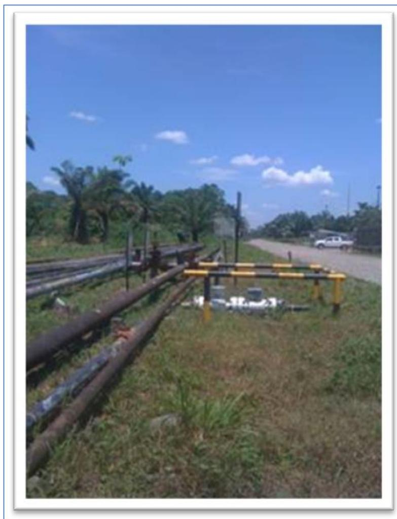
En esta fotografía se ve el derecho de vía de 30 metros de ancho que se utilizaba en el pasado (otros proyectos) para la construcción de líneas de flujo y vías.
