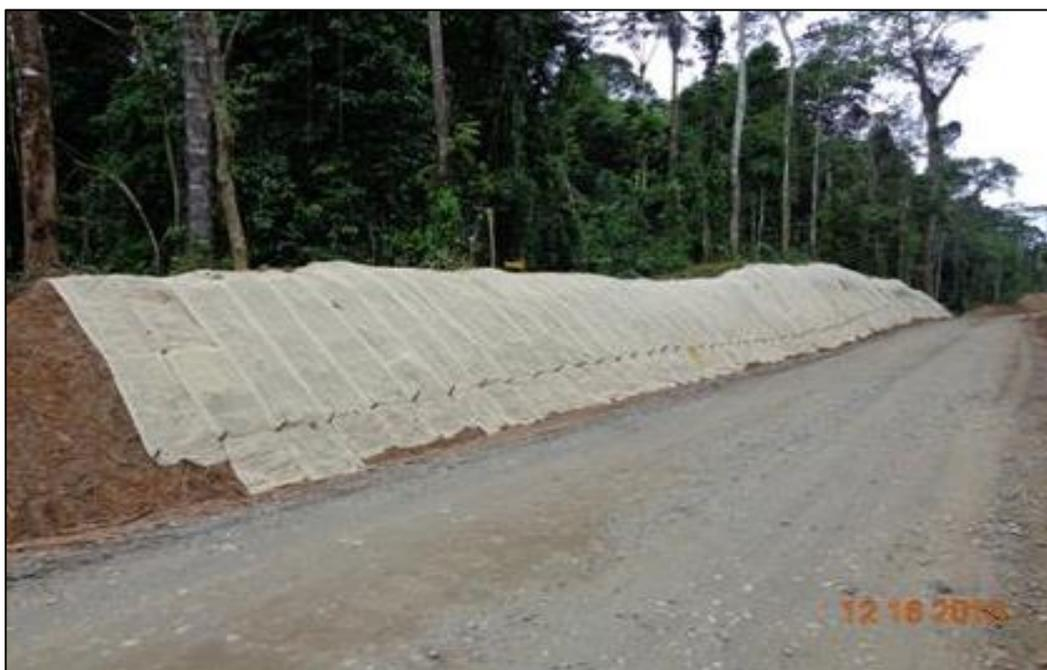
COLOCACIÓN DE MANTAS PARA AYUDAR AL PROCESO DE REFORESTACIÓN EN TALUDES
