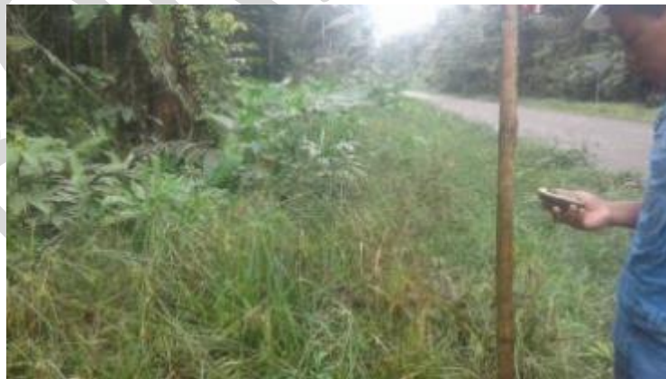
FIGURA N° 108.- INICIO DE LOS TRABAJOS DE EXCAVACIÓN DE PRUEBAS DE PALA
