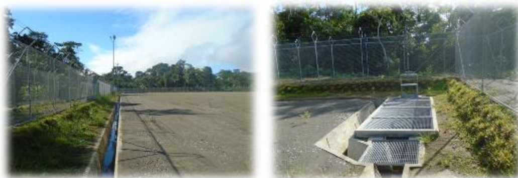
FIGURA N° 118.- SISTEMA DE CUNETAS Y SEPARADOR API
