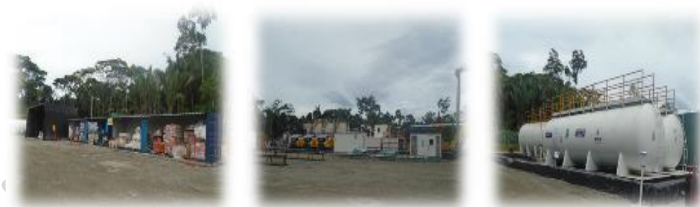
FIGURA N° 121.- INSTALACIÓN DE EQUIPOS DEL TALADRO
