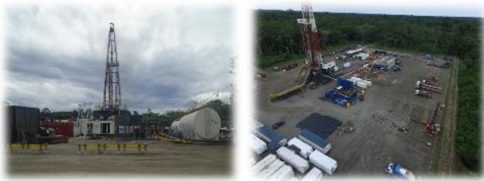
FIGURA N° 122.- PERFORACIÓN DE POZOS
