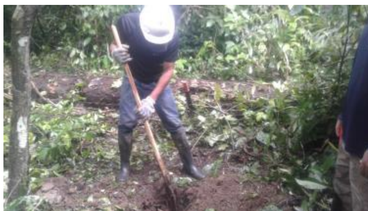
FIGURA N° 109.- EXCAVACIÓN DE PRUEBAS DE PALA. (ABSISA 3+400)
