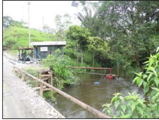
Fotografía N° 1: Caseta de captación de agua tipo, Petroamazonas EP
