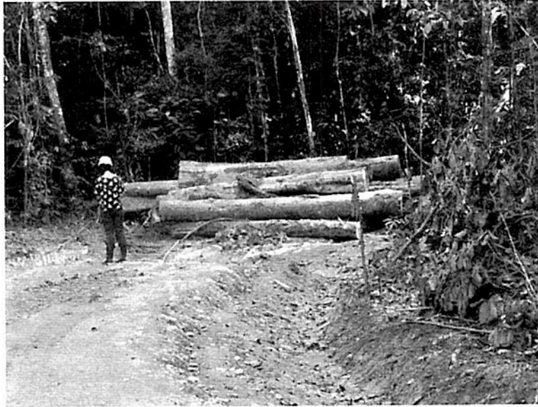
Finalización de la vía en construcción
