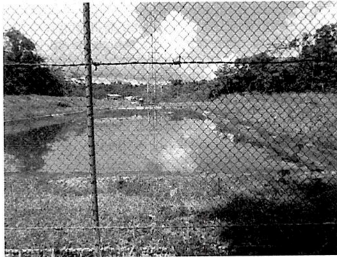
Piscina presuntamente de agua lluvia al interior de la plataforma Apaika
