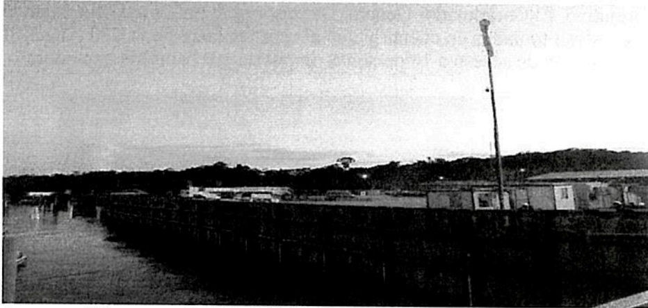
Acceso al bloque petrolero N° 43: Instalaciones de Petroamazonas EP
