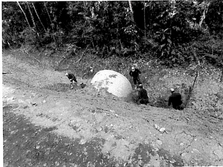
Trabajos de colocación de alcantarilla
