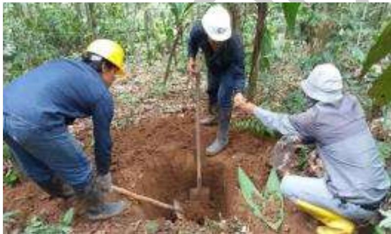
FIGURA N° 17.- EXCAVACIÓN DE PRUEBAS DE PALA.
