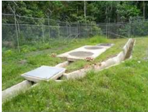
FIGURA N° 26.- SEPARADORES API - AGUAS PLUVIALES TIPO
