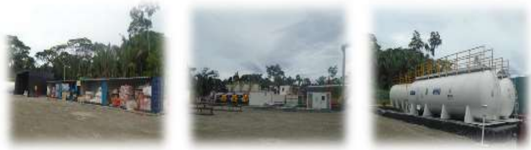
FIGURA N° 7.- EJEMPLO DE INSTALACIÓN DE EQUIPOS DEL TALADRO
