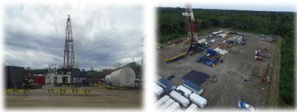
FIGURA N° 8.- EJEMPLO DE PERFORACIÓN DE POZOS
