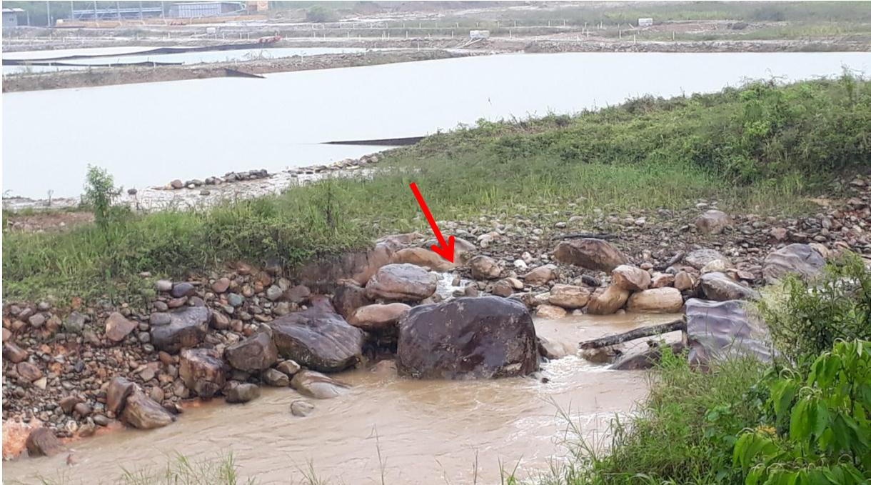
*Figura 7: descarga descontrolada de agua de las piscinas de sedimentación al Río Tundayme y aguas turbias de un brazo del Río Tundayme. Fuente: Colectivo de Geografía Crítica del Ecuador 2019.*
