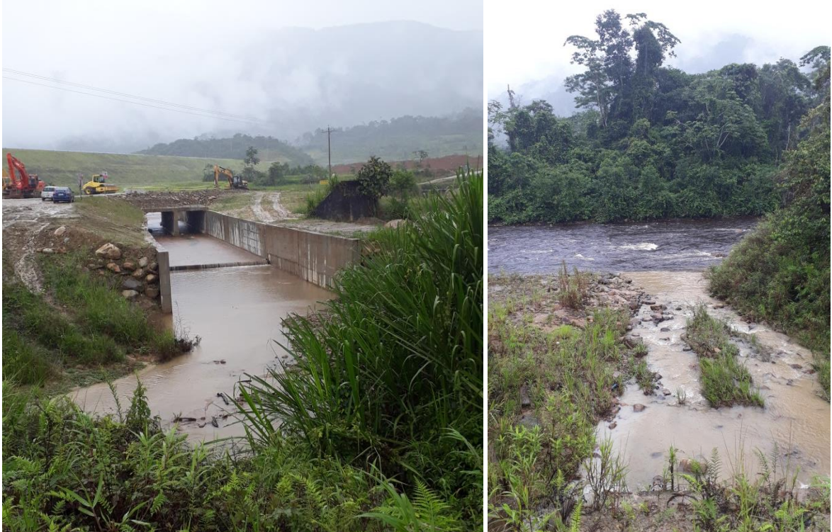
Figura 9: Canalización del Río Tundayme y descarga de agua turbia desde el proyecto hacia el Río Quimi. Fuente: Colectivo de Geografía Crítica del Ecuador 2019.
