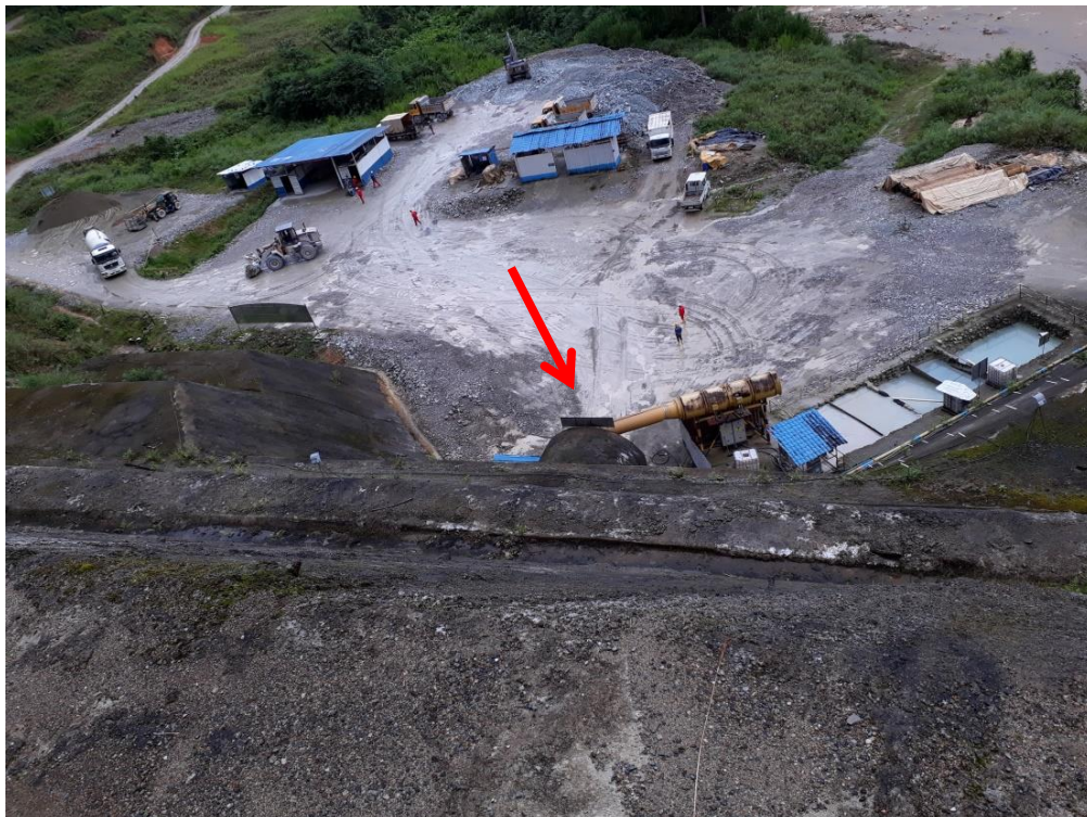
Figura 6a y 6b: construcción de túneles de desvío de río (con flecha roja) y intervención en el cauce natural del río. Fuente: Colectivo de Geografía Crítica del Ecuador 2019.
