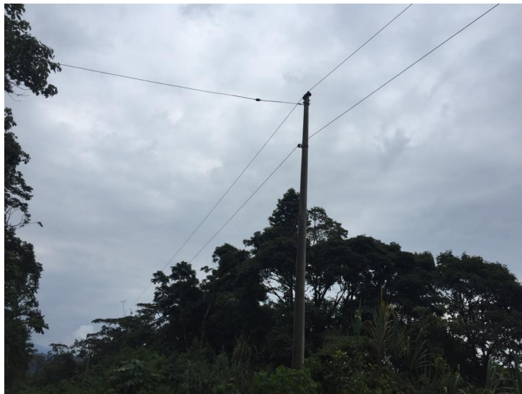
Imagen 1: Mejora del Cableado eléctrico
