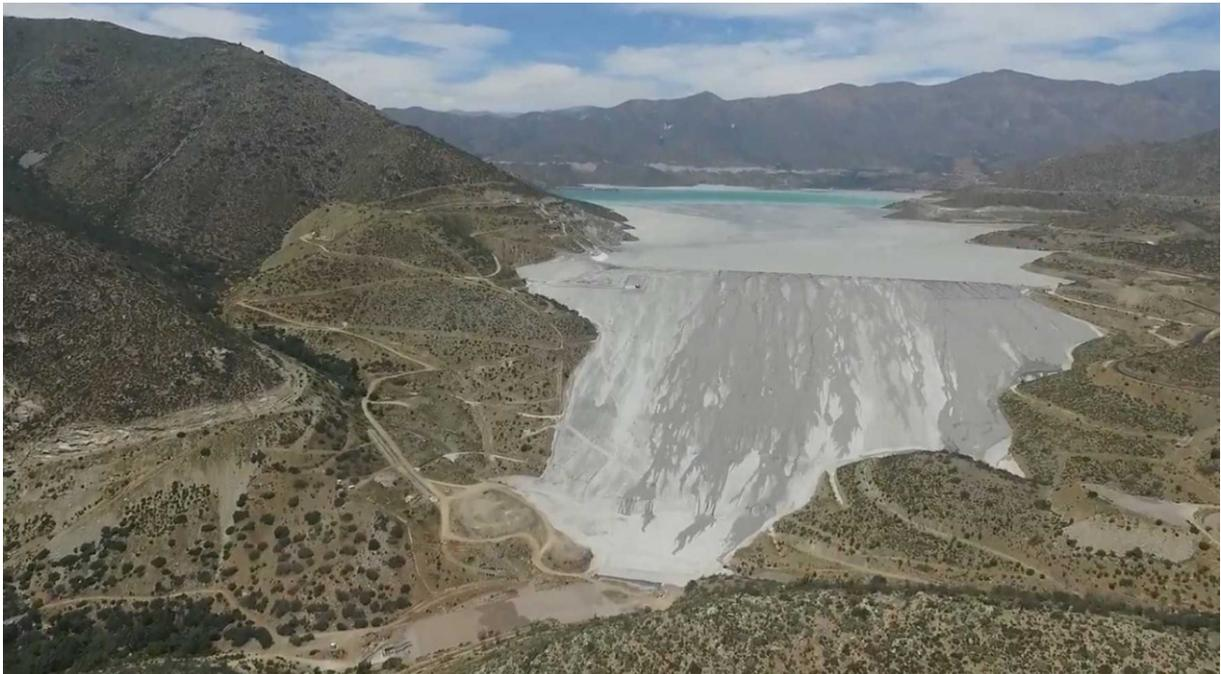
*Figura 1: depósito de relaves El Mauro en el proyecto de minería de cobre Los Pelambres en Chile: vista de arriba y de frente. Fuente: [www.relaves.org](http://www.relaves.org).*
